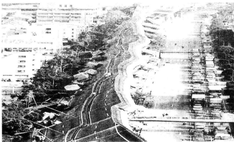
图 1-12 日本地震桥梁的破坏
