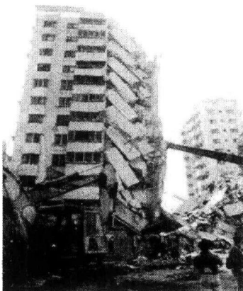
图 1-9 结构失稳引起的破坏
