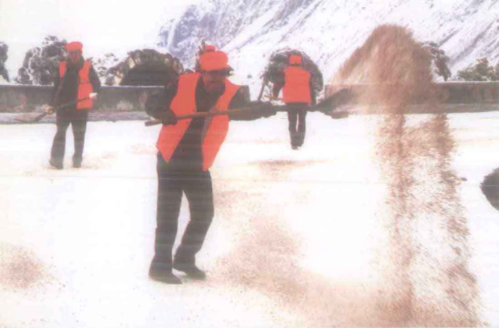
黔西北高寒地带的养路工坚守岗位,防冻防滑。
