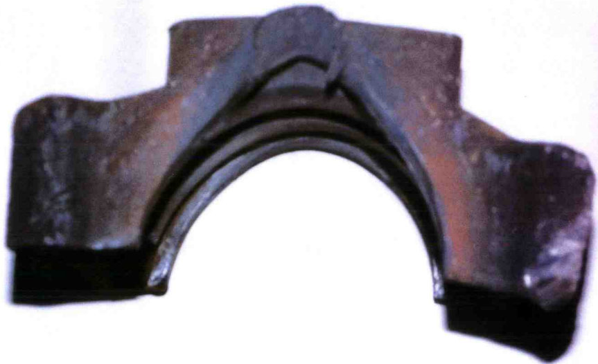
图 1-1-2 承载鞍损坏情况
