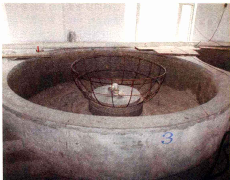
水泥孵化环道
