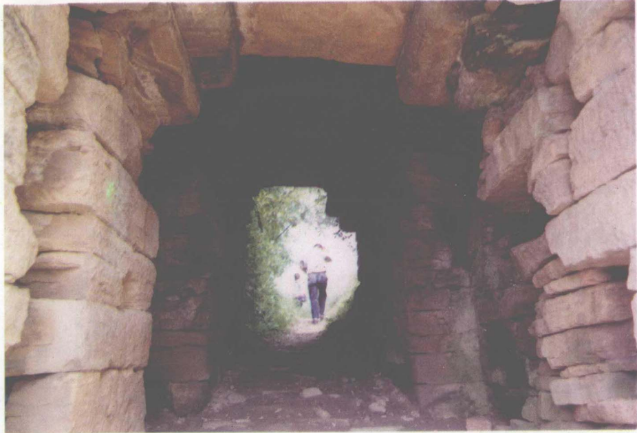
养马城东城门内景
