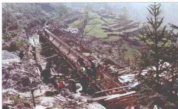
抢修后坝大堰水毁工程 马志明 摄
