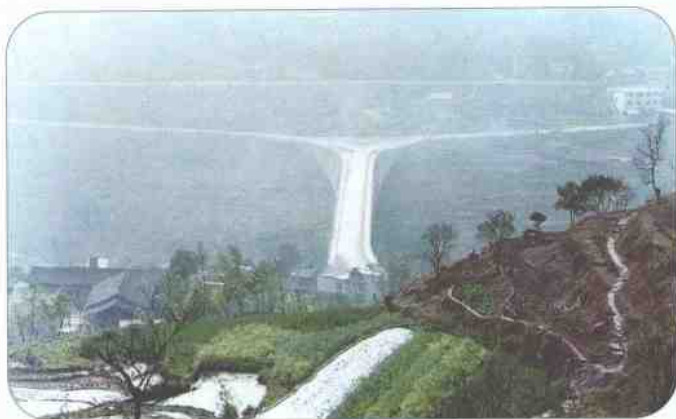
过境公路大田口大桥 赵咏华 摄
