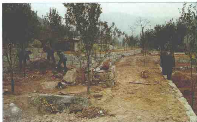
鲢鱼办事处大塘村坡改梯工程 马志明 摄
