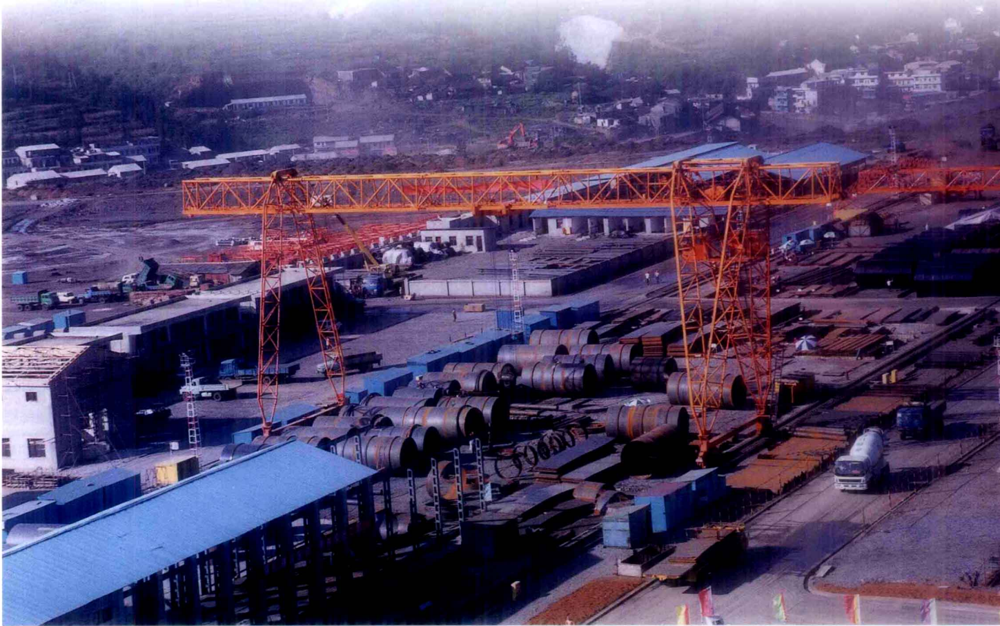
新开工的盘南电厂一角 (洪林 摄)
