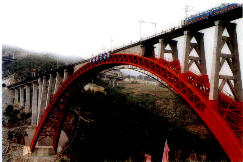
水柏铁路北盘江大桥 (谢鹏 摄)
