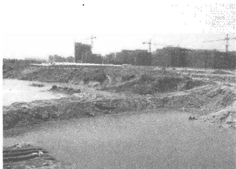
事故现场筑坝截污
