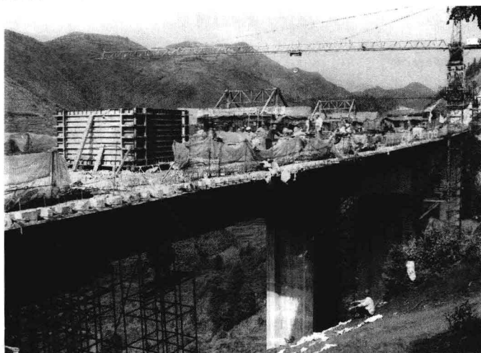
图 1-2 钢筋混凝土薄壁桥墩
