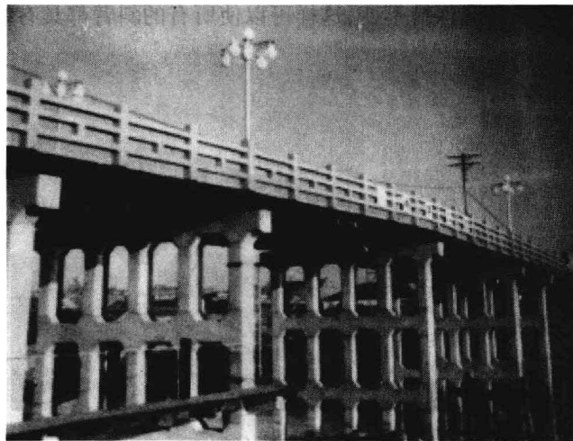
图 1-5 钢筋混凝土柔性排架桩墩
