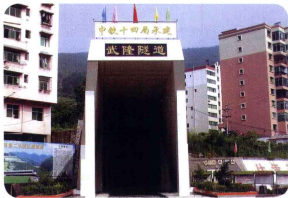
→ 渝怀线武隆隧道穿越城区
