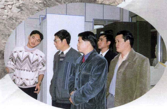
普安县程控电话“九五”期间正式建成投入使用。县委、政府领导在县电信局机房听取技术人员的汇报
