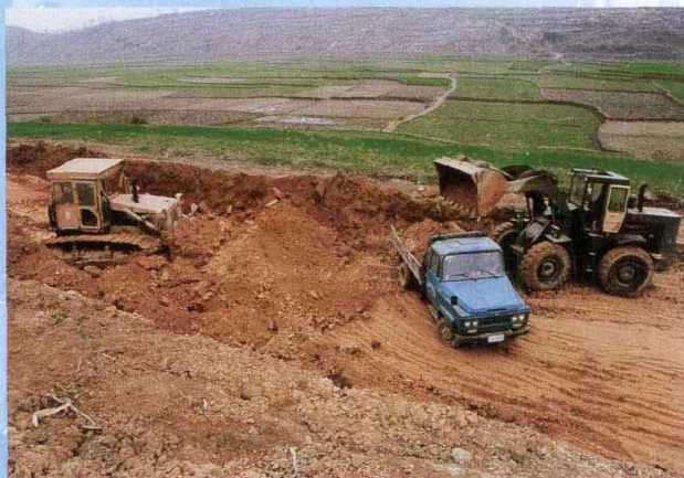
正在建设中的顶兴高等级公路
