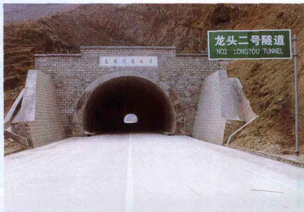
已建成顶兴高等级公路隧道
