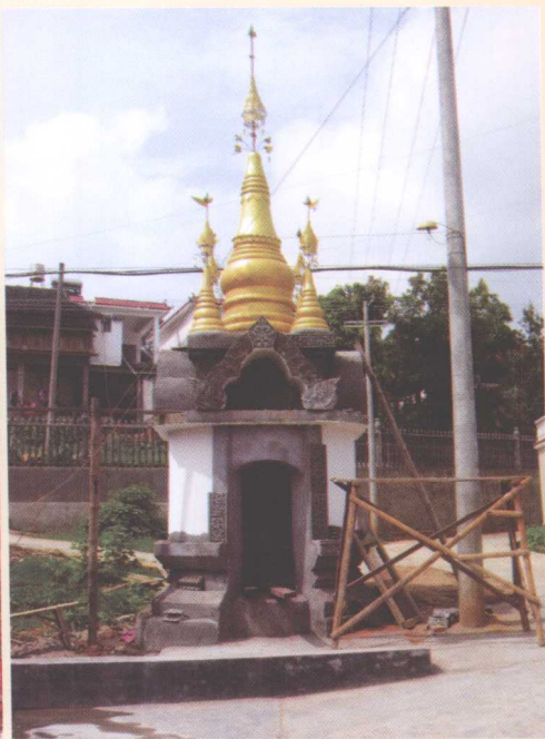
正在修建的水井
