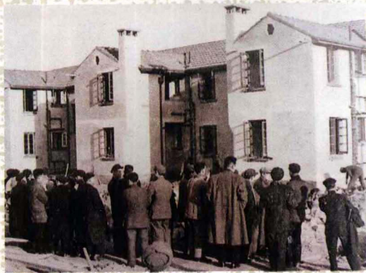
1952年上海市各界人民代表会议代表参观上海解放后新建的第一个工人住宅区——曹杨新村
