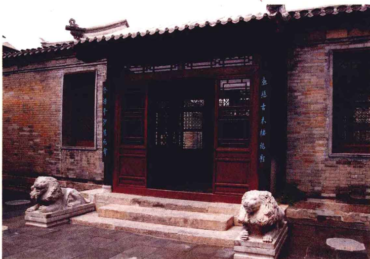
→ 石家大院女院过厅，装隔扇门与横披窗
