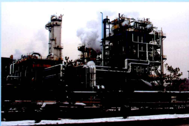
辽阳石化公司 20 万吨 / 年环氧乙烷 / 乙二醇装置
