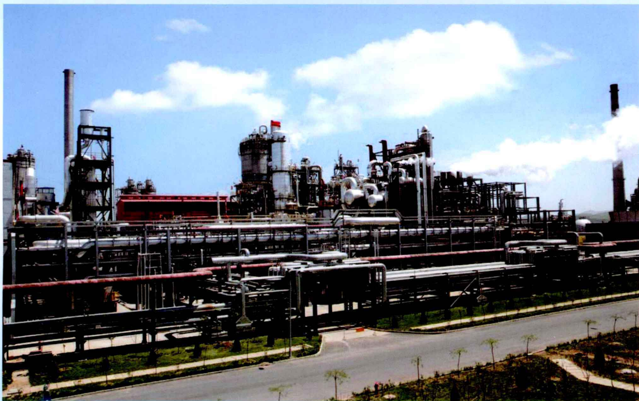
辽阳石化公司 80 万吨 / 年 PTA 装置全景
