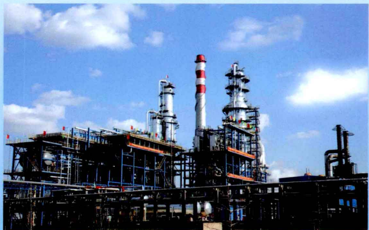
辽阳石化公司 550 万吨 / 年俄油加工装置
