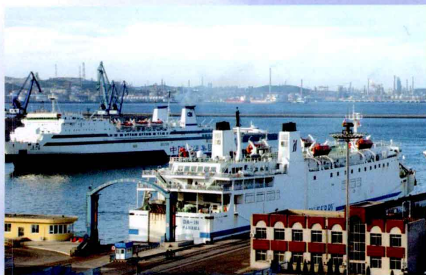
客运滚装码头
