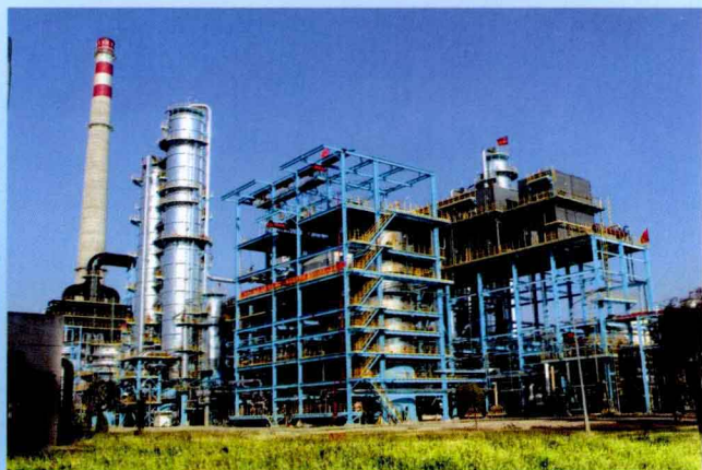
辽阳石化公司 45 万吨 / 年对二甲苯装置
