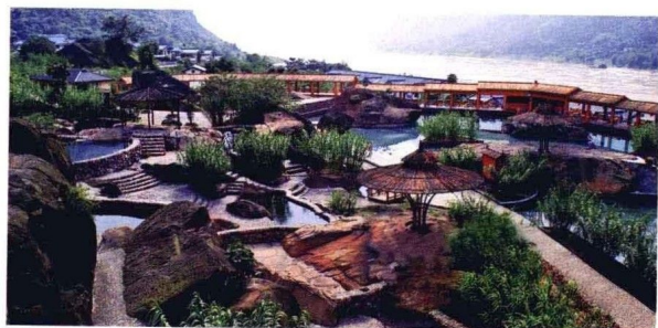
搬迁前的水富大峡谷温泉
