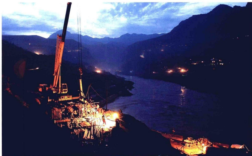
永善县溪洛渡电站建设区
