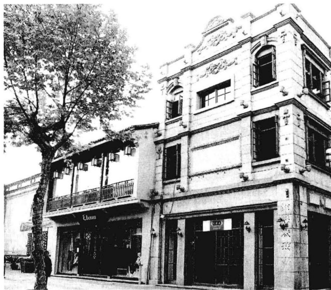
旧时的羊坝头一带银行店铺林立，留下了很多富有特色的建筑，今天这里已经成为了杭州近代建筑历史的博物馆
