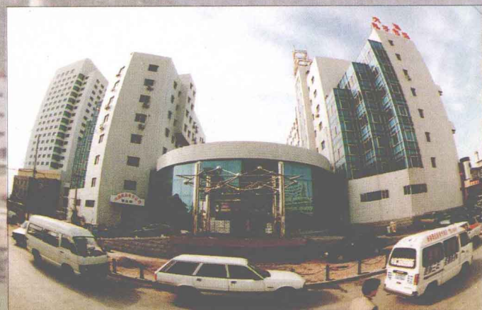
正在建设的大连市信息产业化基地星海高技术中心
