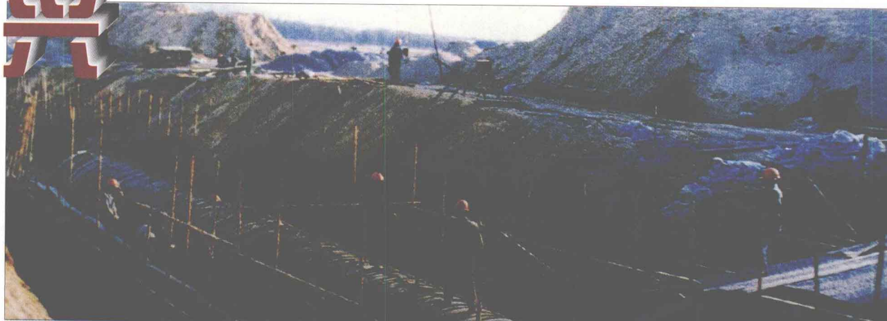
支持基础设施建设，图为引碧入连工程施工现场
