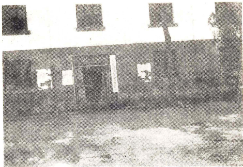
开阳县人大常委会办公楼
