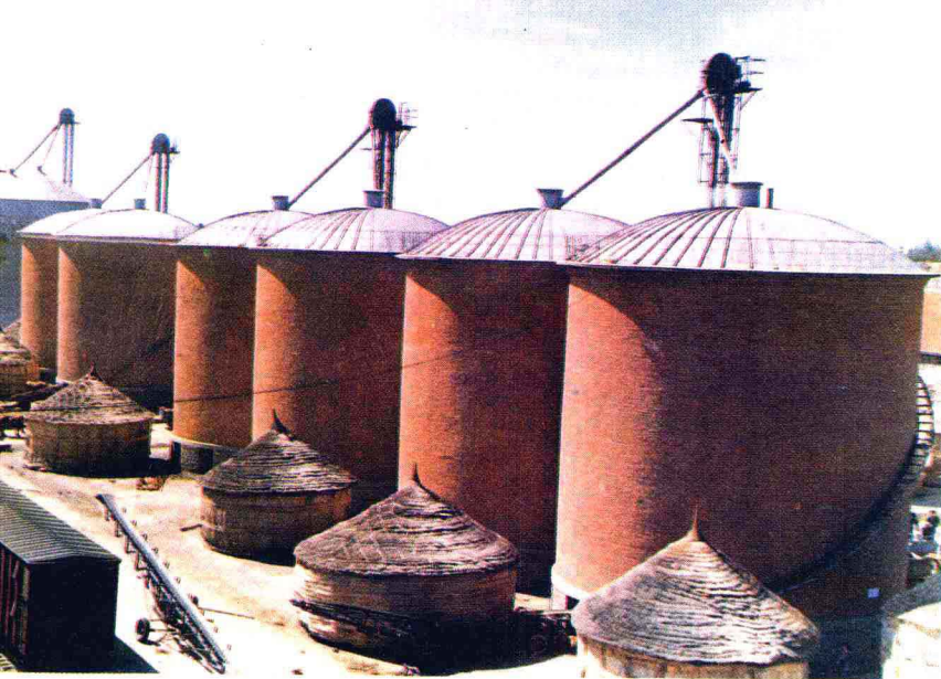
虎林粮库储粮仓
