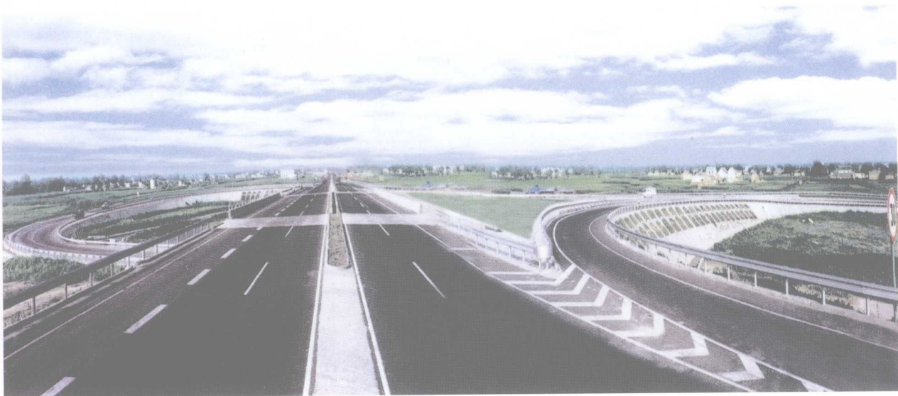
连宁高速公路绕城段立交
