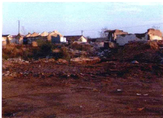
山东桓台县马桥镇后金村拆迁现状
