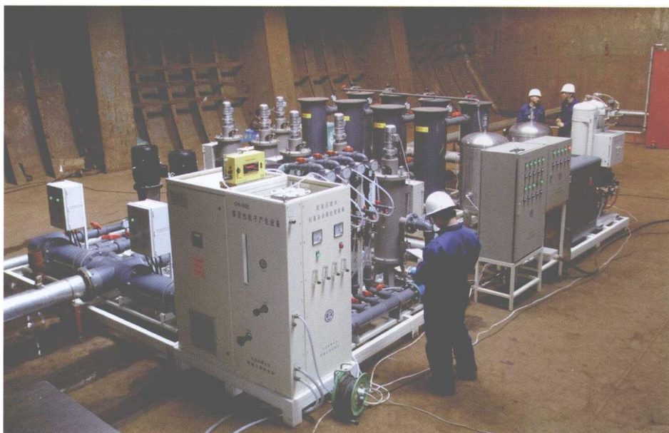
彩图13 装在“育龙号”舱内250 t/h 的压载水全套处理设备
