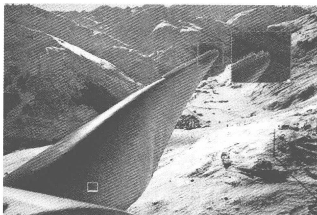
图 1-3 瑞士 Gütsch 测试站风力涡轮叶片上的覆冰 (经过瑞士 Meteotest 允许复制)
