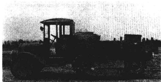
■ 马克 AB 型半履带卡车于 1923 年在阿伯丁试验场进行测试，但是该车的 4 缸 28 马力发动机明显动力不足。
