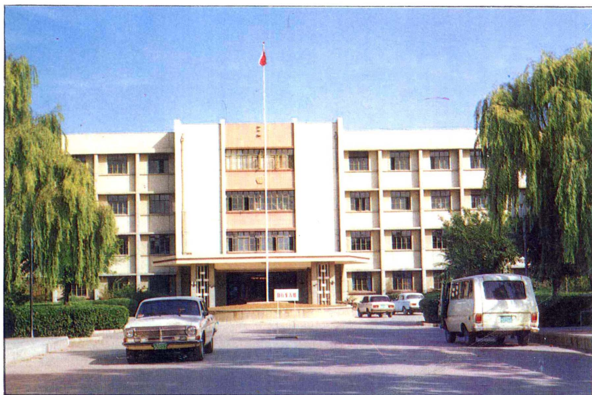
宁阳县人民政府办公楼
