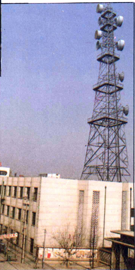
县邮电局微波塔
