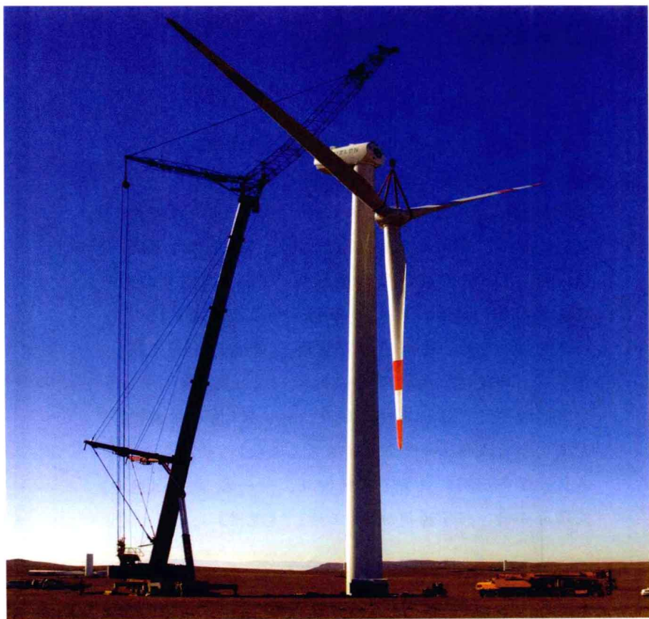
建设中的风力发电机组
