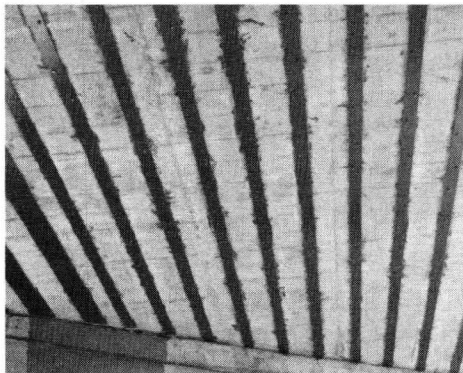
图 1-4 空心板底粘贴钢板加固
