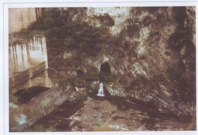
猫跳河四级电 站的喀斯特管 道渗漏
