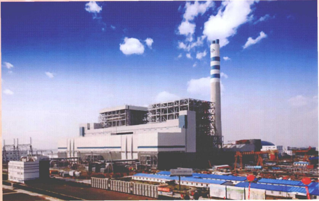
2009年11月30日，国家开发投资公司北疆电厂2号超超临界燃煤发电机组圆满完成168小时满负荷试运行。2号机组的顺利投产发电，标志着国投北疆电厂一期工程竣工投产
