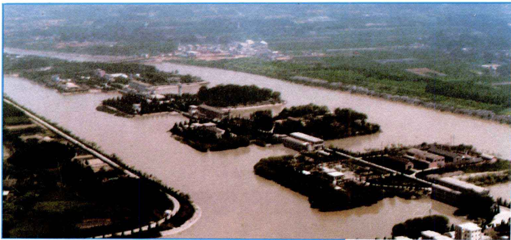
◇ 1976年建成 的国内最大电 力灌溉泵站—— 江都抽水机站， 抽水能力483 米 3 /秒。
