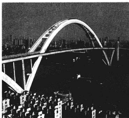
图 1-10 上海卢浦大桥
