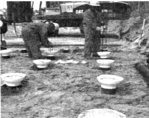
图 1-7 安置塑料套管模子及放置钢筋
