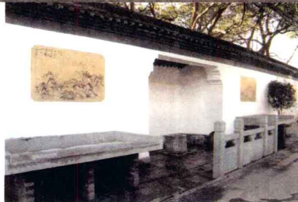
修缮后的凤凰山脚路井
