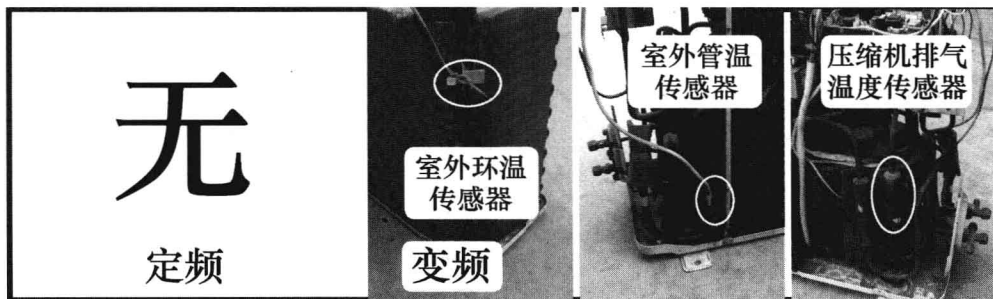
图 1-15 室外机温度检测器件
