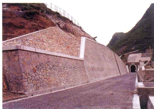
株六复线莫家地样板工程 (王述慎 摄)
