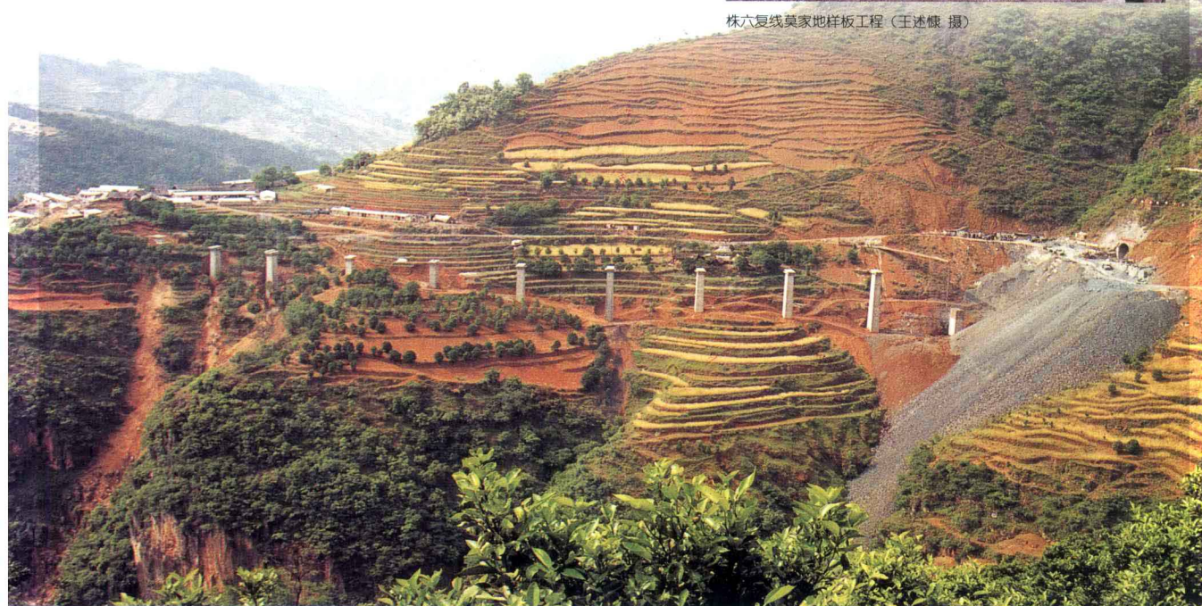
水柏铁路发耳段施工场面 (陈绍荣 摄)
