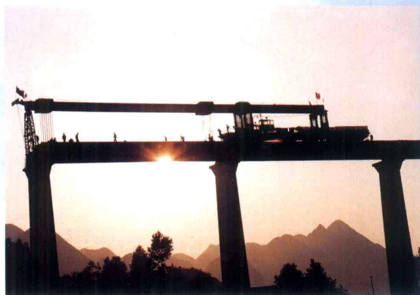
内昆引入线唐家寨大桥 (王述慎 摄)
