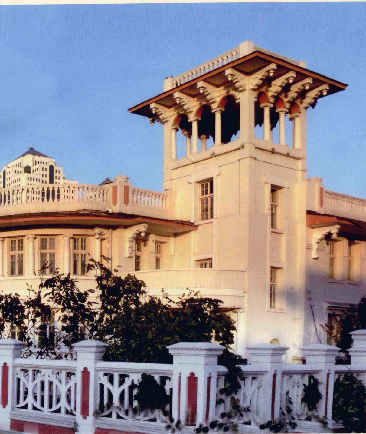
马可波罗广场上的小洋楼，是 20 世纪 20 年代按照意大利地中海沿岸的建筑风格建造的，展现了中世纪的浪漫特色，这种风格的建筑目前在意大利本土都很难找到了。
