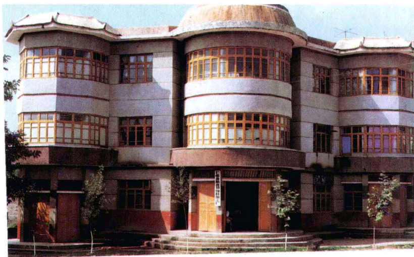
上图 饲料厂办公楼
