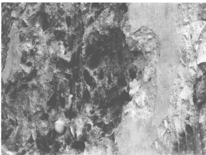
图 1-2 混凝土剥落
