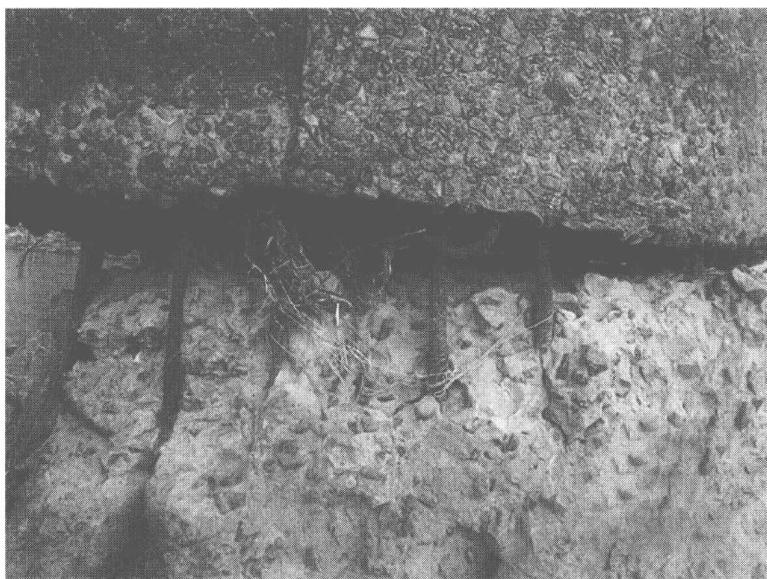
图 1-3 混凝土露筋
