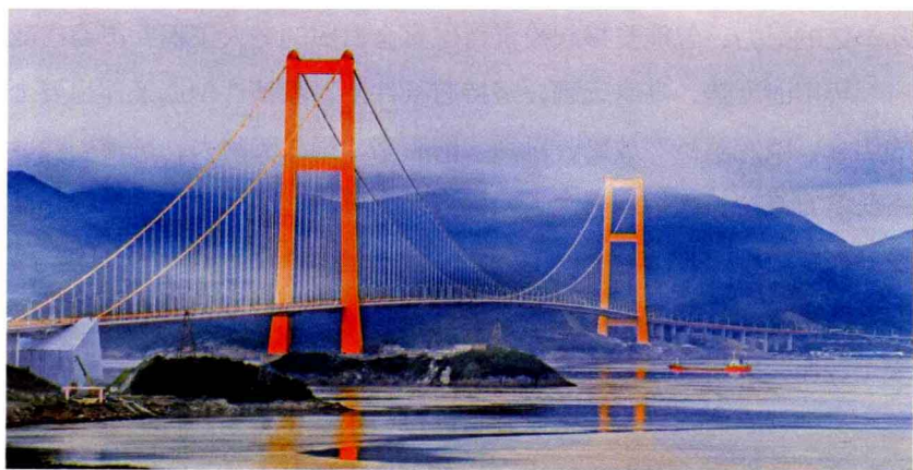
舟山跨海大桥——西堠门大桥
