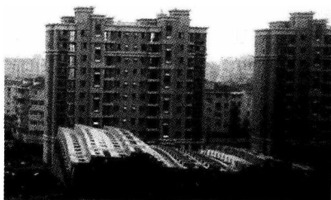
图 0-6 “莲花河畔景苑”楼梯倾覆现场
