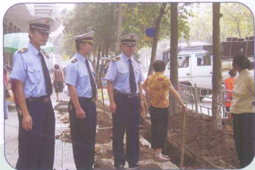
查处不文明施工
