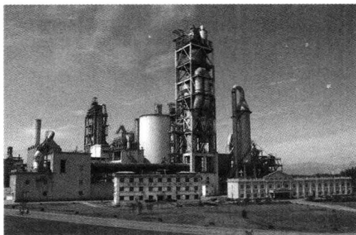
图 1.5 我国的基础产业——水泥产业中的水泥生产厂实景
