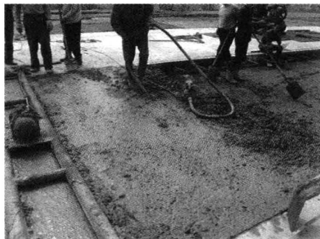
图 1.6 人工摊铺水泥混凝土路面
