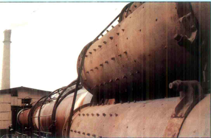
十万吨普硅水泥生产线悬窑。
