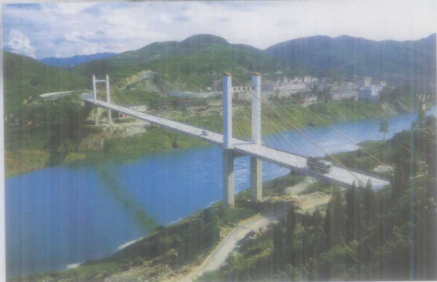
贵阳至遵义公路1997年11月29日建成通车。图为贵遵公路乌江大桥
