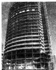
图 0-6 钢-混凝土混合结构
