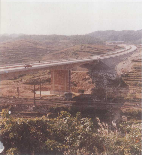
都拉营转体大桥跨越都拉营铁路车站,被称为"桥梁泰坦尼克号"(钟蔚摄)
