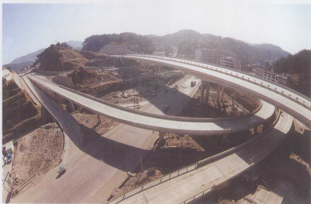
贵阳东北绕城公路东出口新添寨互通式立交桥(贺培铨摄)
