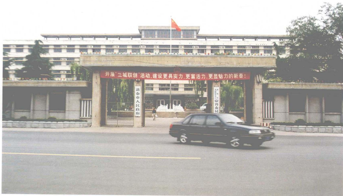
市政府办公楼
