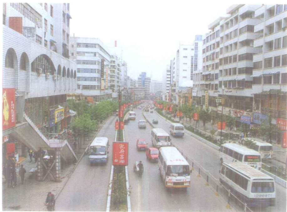
交通大发展，城建面貌新。图为中华路新景观。 李 晶 摄
