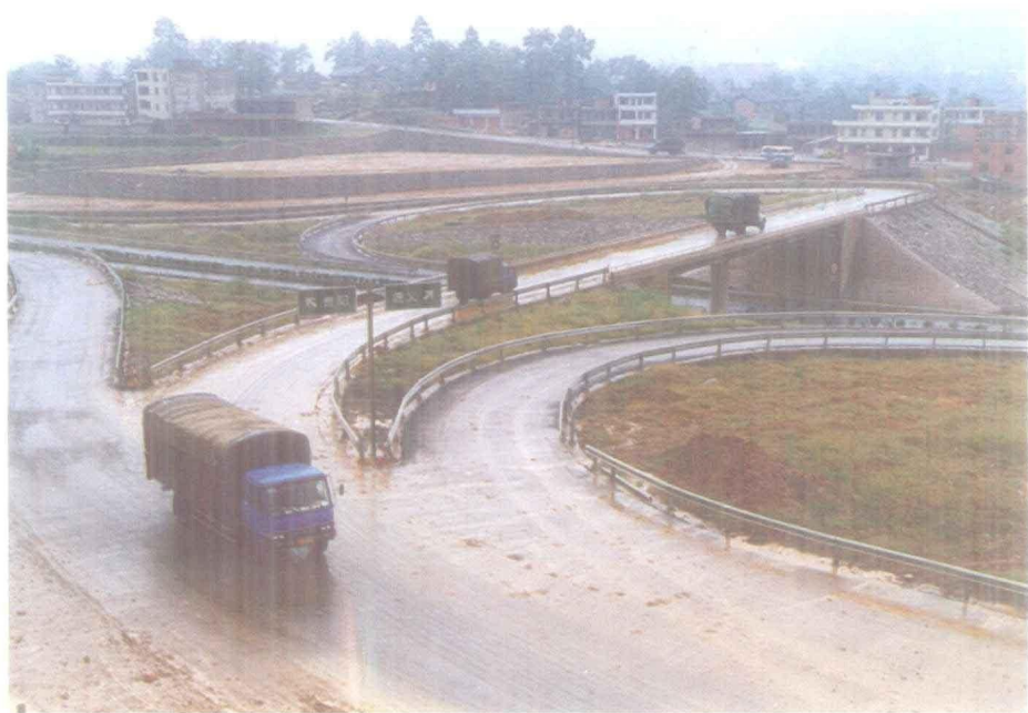
贵遵高等级公路忠庄立交桥。
