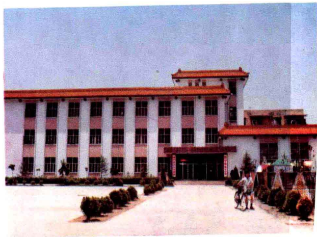
2. 县总工会大楼
